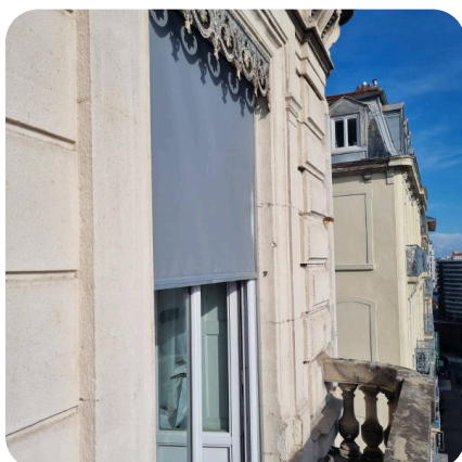
Store vertical sur la porte-fenêtre d'un immeuble ancien
