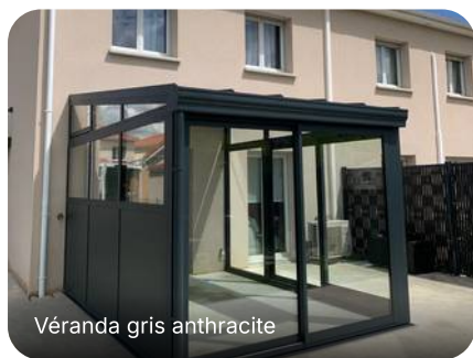
Véranda fermée par de grandes baies coulissantes
